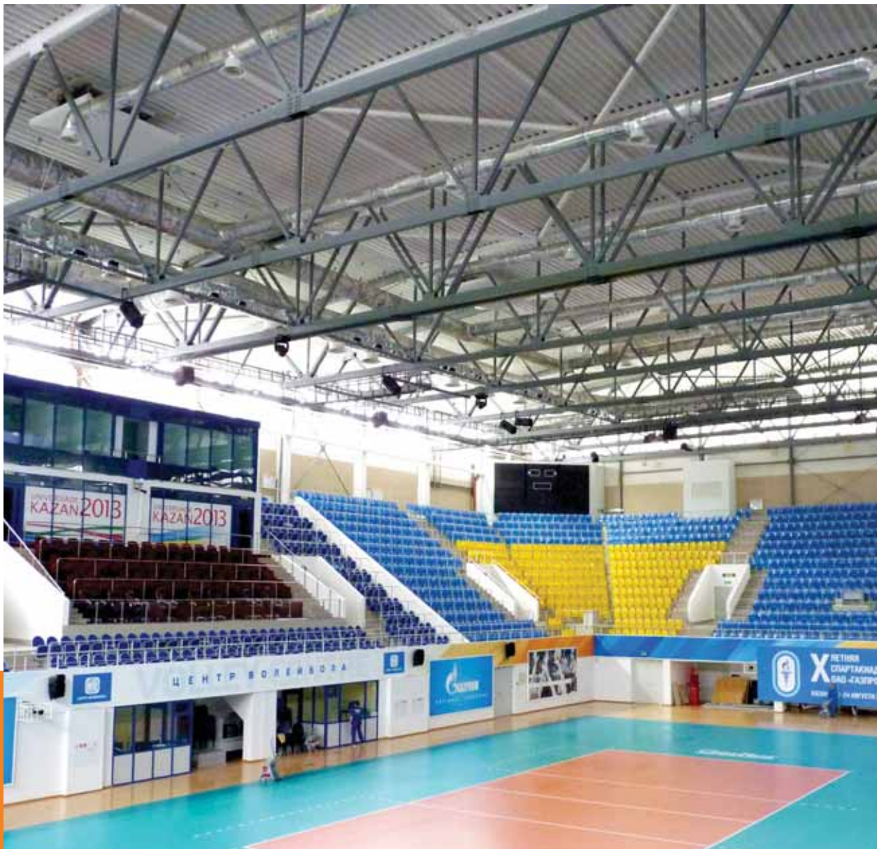
Спортивный комплекс «Центр волейбола», г. Казань / Sonaspray K-13, белый, 20 мм / 3 340 кв. м
