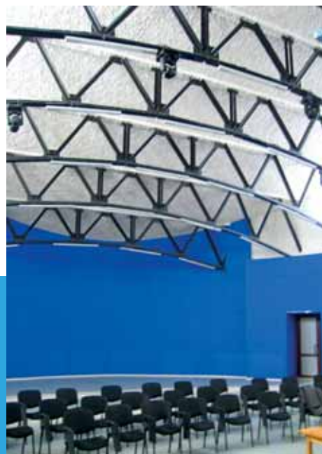
Загородный клуб «Фазенда» (конференц-зал), г. Уфа / Sonaspray K-13, белый, 25 мм / 340 кв. м
