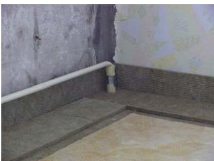
**3. Прокладка коммуникаций.** Во избежание образования «акустических мостиков» трубы отопления оборачиваются виброизолирующей лентой Вибростек-V300 (или аналогом). Электрические кабели и другие коммуникации можно
