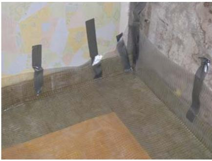
**4. Гидроизоляция.** Поверх слоя звукоизолирующих плит Шумостоп укладывается полиэтиленовая армированная пленка толщиной 200 микрон также с заведением краев на стены. Это необходимо для того, чтобы при устройстве стяжки плиты не намокали и не теряли свои акустические и механические свойства. Края пленки должны заводиться друг на друга с нахлестом в 50 мм, а полученный стык проклеиваться строительным скотчем шириной 50 мм.
