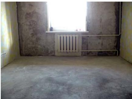
**1. Подготовка поверхности.** Основанием для устройства плавающего пола может служить как железобетонное перекрытие, так и существующая стяжка. Поверхность пола очищается от строительного мусора. При наличии старого напольного покрытия оно удаляется, что позволяет максимально сэкономить высоту помещения. Пол должен быть ровным, перепад высот не более 1-2 см по всей площади комнаты. При необходимости выполняется черновая бетонная стяжка в качестве выравнивающего слоя.
