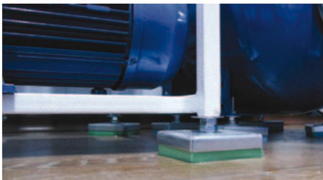
**Виброизоляция насосного оборудования**
