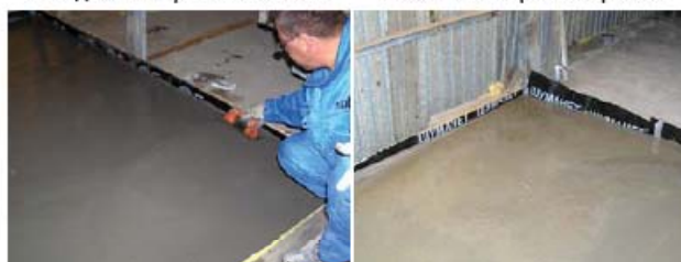
Выравнивание стяжки
