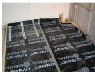
Укладка материала с заведением краев на стены
