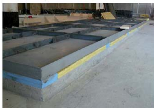
Устройство виброизолирующего фундамента
