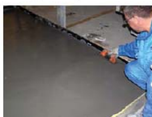
Выравнивание стяжки
