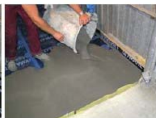
Устройство выравнивающей стяжки поверх материала
