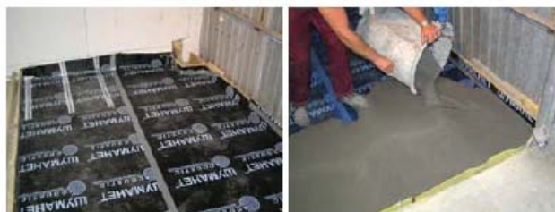
Укладка материала с заведением краев на стены
