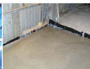
Фрагмент конструкции звукоизолирующего пола
